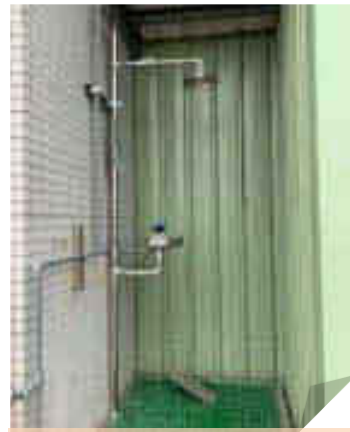
水处理区紧急冲淋设备
