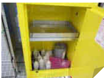
化学品贮存柜设置防漏承接盘
